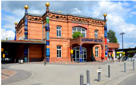
Das Bahnhofsgebäude von außen
