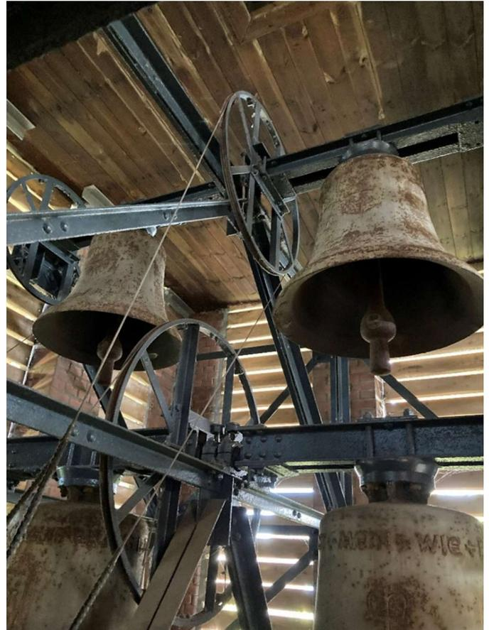
Im Turm der Wichernkirche befinden sich vier Glocken, die in einem Stahlgerüst verankert sind. Gegossen wurden sie aus Stahl um 1958 herum. Sie sind unterschiedlich groß und besitzen unterschiedliche Töne (a`h`/d`/e``). Die größte wiegt immerhin 380 Kilo. Interessant sind ihre eingravierten Botschaften:
